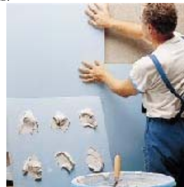
точечное приклеивание изоляционной панели
