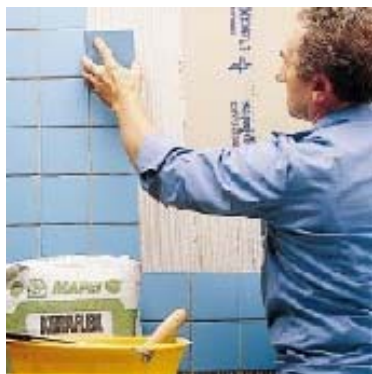
укладка плитки на гипсокартон с помощью KERAFLEX
