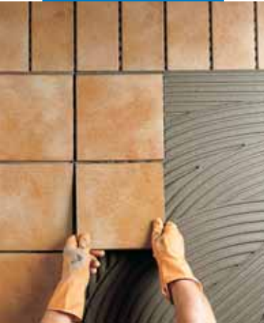
Укладка клинкерной плитки снаружи помещений
