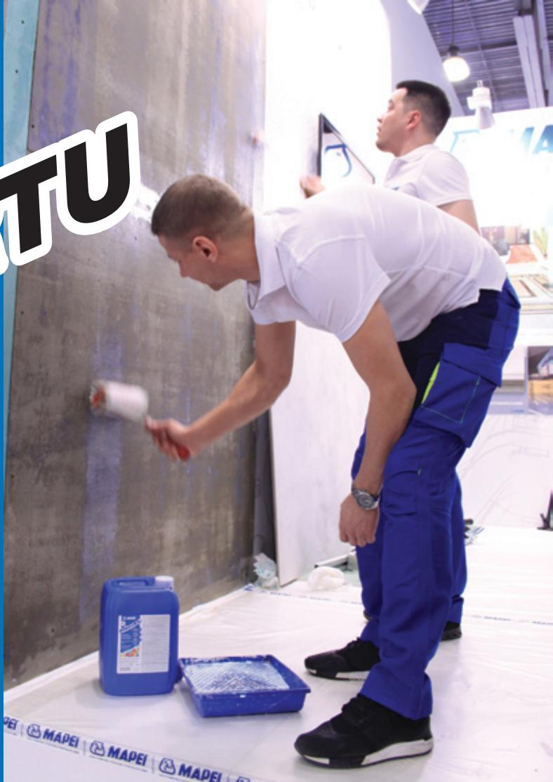
удаление обоев при последующих ремонтах. При использовании в качестве грунтовки под самовыравнивающиеся смеси **Primer RTU** уменьшает количество воздушных пузырьков и обеспечивает необходимую удобоукладываемость растворной смеси.
